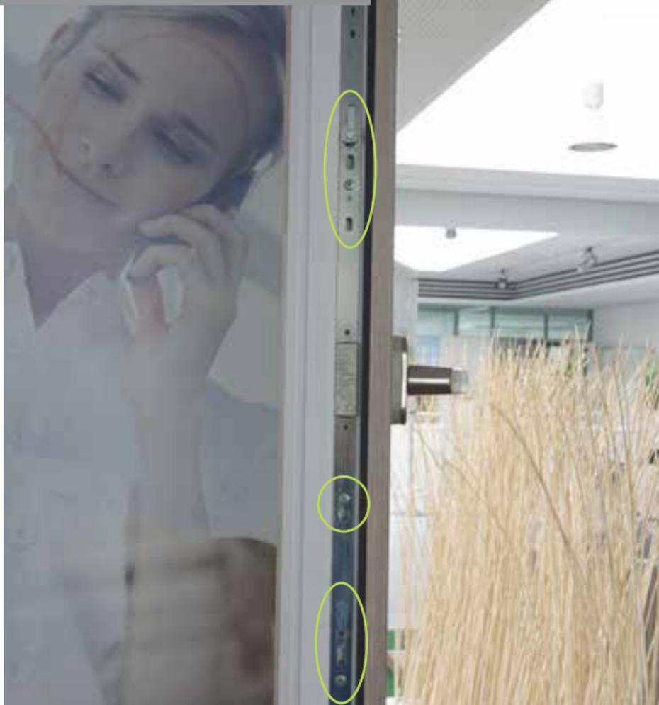
/// Die Einstellarbeiten an den Beschlägen sowie das Aus- und Einhängen der Flügel sollen nur von einem **Fachmann** durchgeführt werden.
